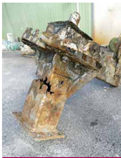
Foto 6.2: Massiv korrodierter Stahlbau eines Tauchmotorrührwerks.
